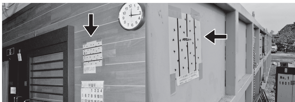
写真 2 避難所内(左)と廃棄物仮置き場付近 (右) の壁面への粘着シートの設置
